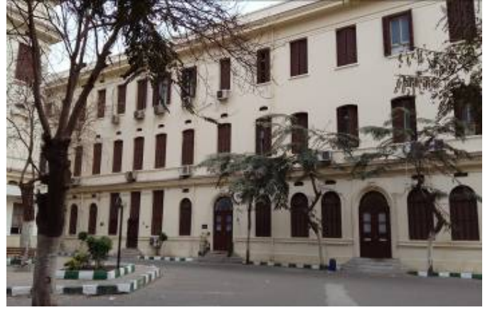
أعمال الإحلال والتجديد بواجهات مبنى مدنى ١ ( مبنى مطبعة الكلية)
