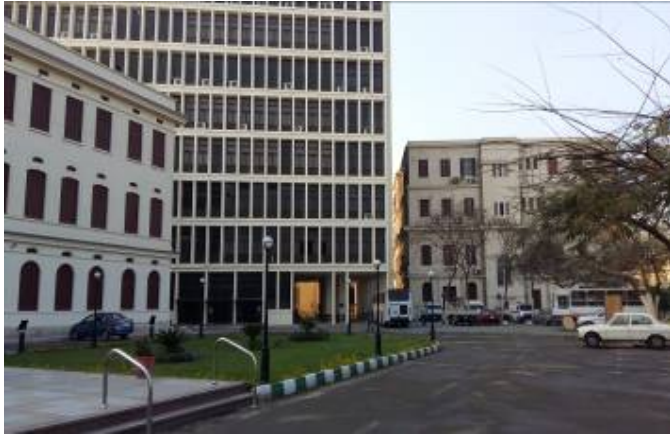
أعمال الإحلال والتجديد بواجهات مبنى ٣ ( مبنى عمارة)
