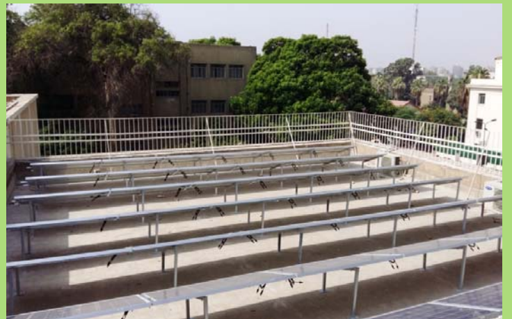
تعلية أسوار سطح مبنى قسم كهرباء قوى ( مبنى ١٦ ) وتركيب وحدات خلايا شمسية
